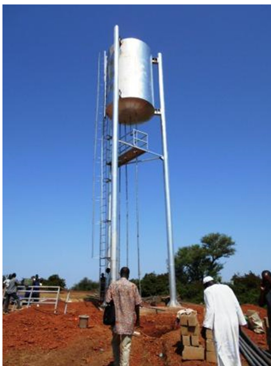
Visite d'infrastructure AEP, crédit : © Bam
