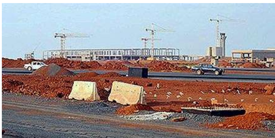
Figure 15.4 : Vue des travaux de construction de l'AIBD 56
