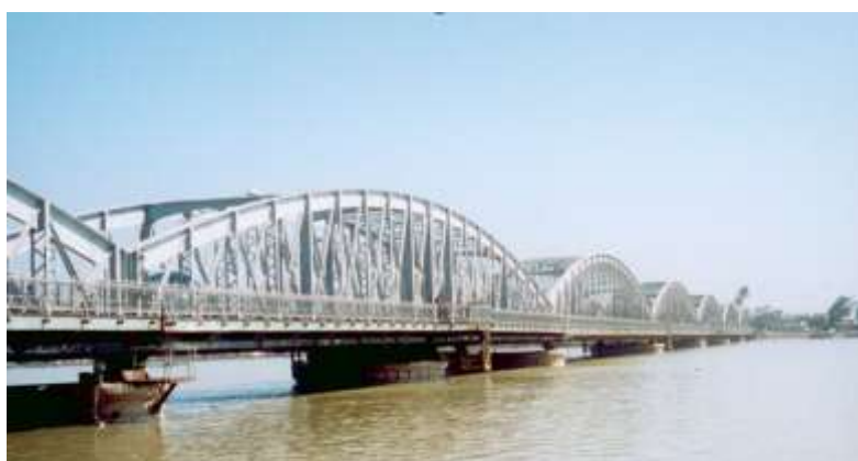
Figure 15.5 : Le pont Faidherbe à Saint-Louis 57
