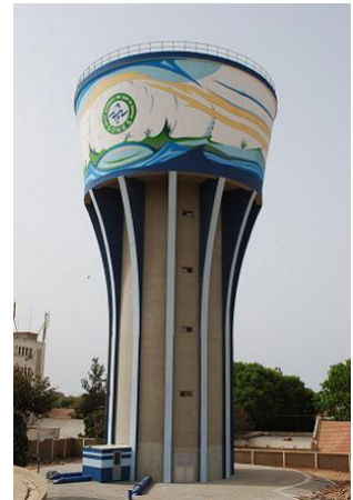
Château d'eau des Madeleines - Dakar
