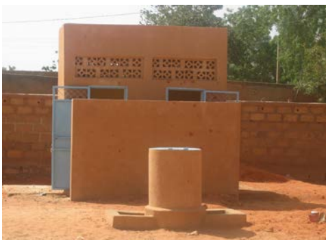
Bloc latrines et dispositif de lavage de mains
