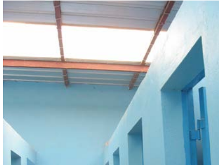
Toit de latrines à Tessaoua vu de l'intérieur du bloc
