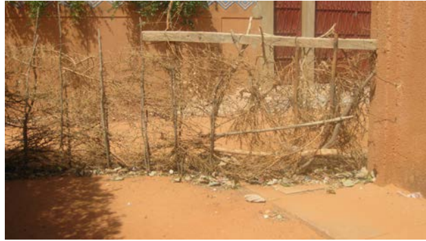
Clôture sommaire de l'école
