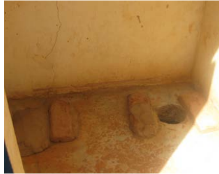
Intérieure de la cabine et trous de défécation utilisés alternativement
