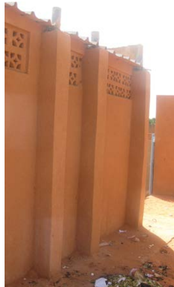
Système d'aération des fosses
