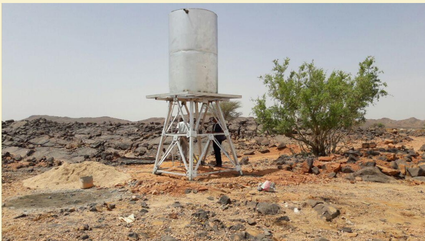
installation réservoir 5 000 L
