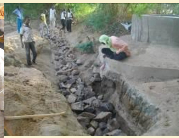
margelle, gabion protecteur
