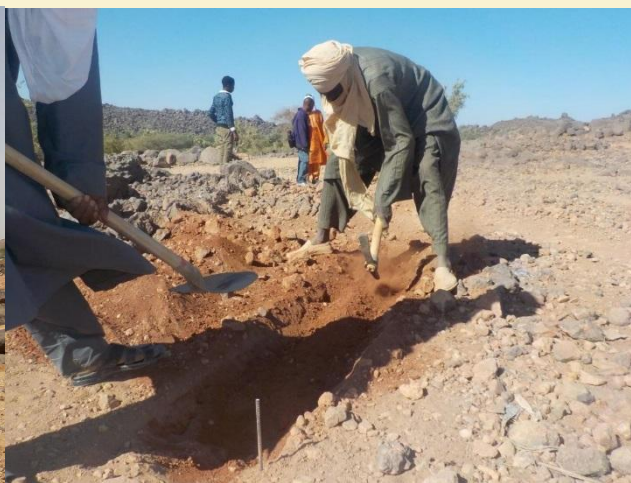
tranchée réseau – câblage
