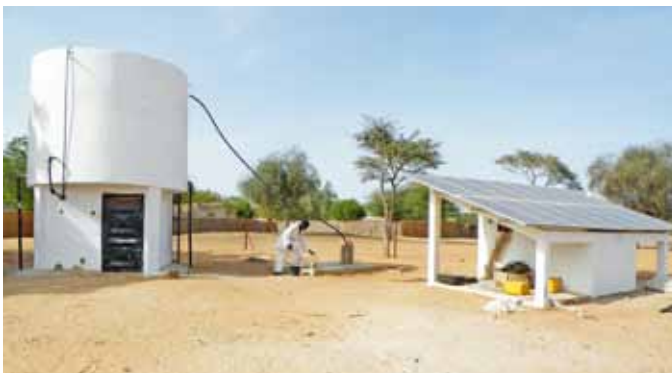
Panneaux photovoltaïques et réservoir d'eau
