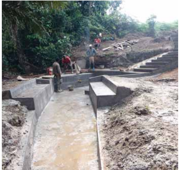
Chantier : escalier permettant de descendre au point d'eau, point d'eau et bancs de lavage
