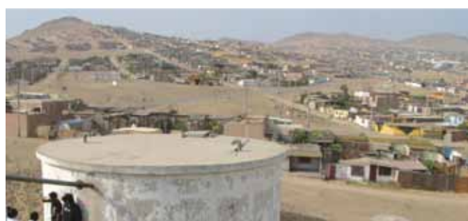
Réservoir d'eau collectif
