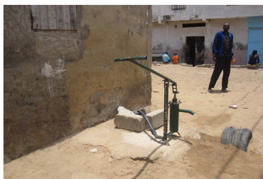
Mini-forage équipé de PJ installée dans la rue
