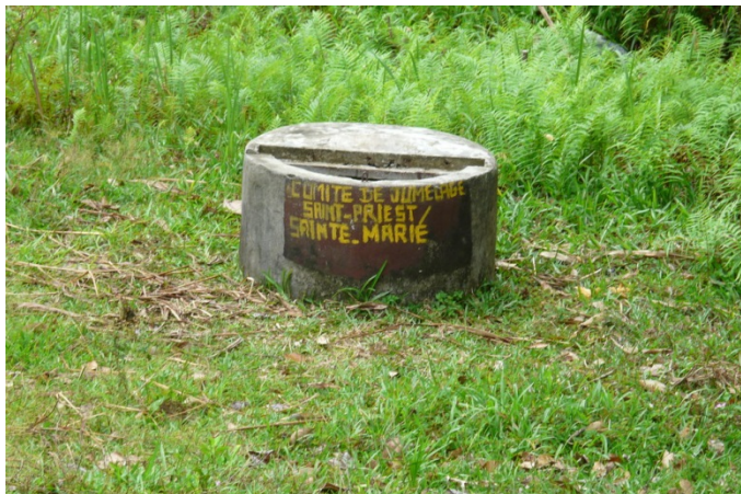
Puits à l'abandon (mission 2008)
