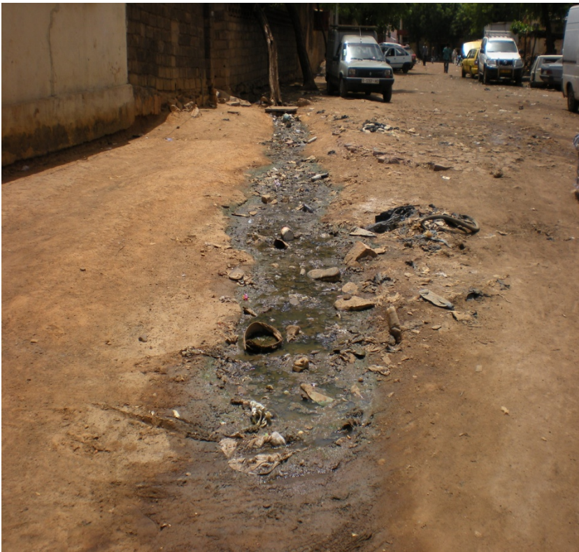
Rue 33 avant les travaux
