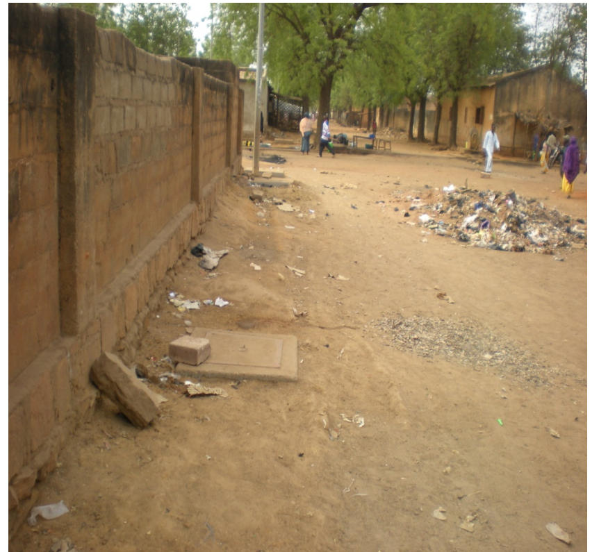
Rue 33 après les travaux
