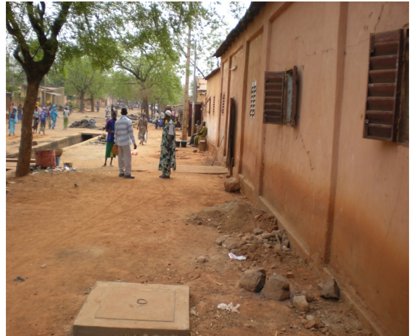
Rue36 D après les travaux
