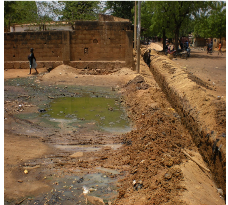
Rue 36 G pendant les travaux
