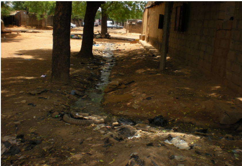
Rue 34 avant les travaux
