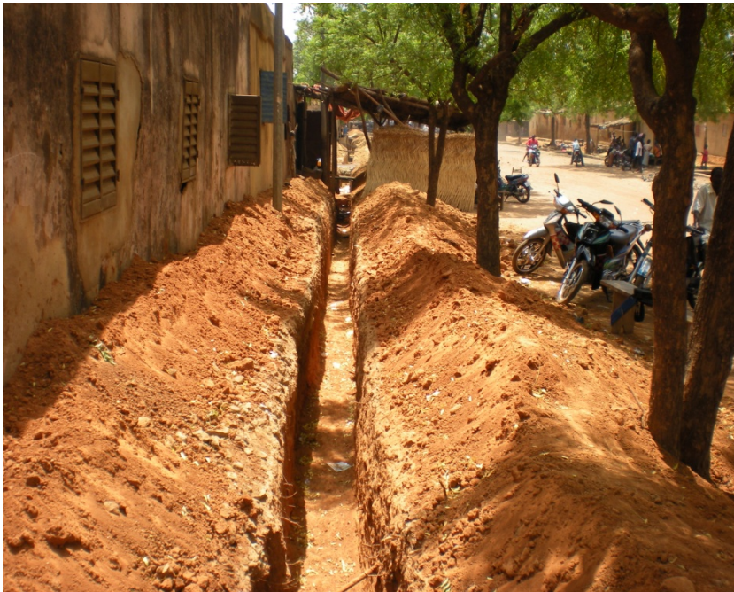
Rue 36 D pendant les travaux
