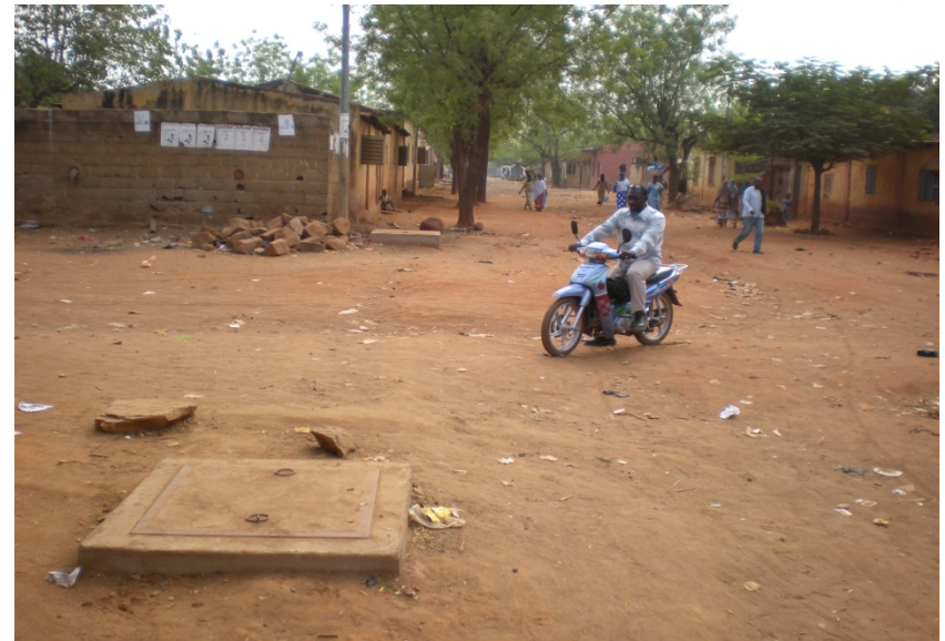
Rue 34 après les travaux
