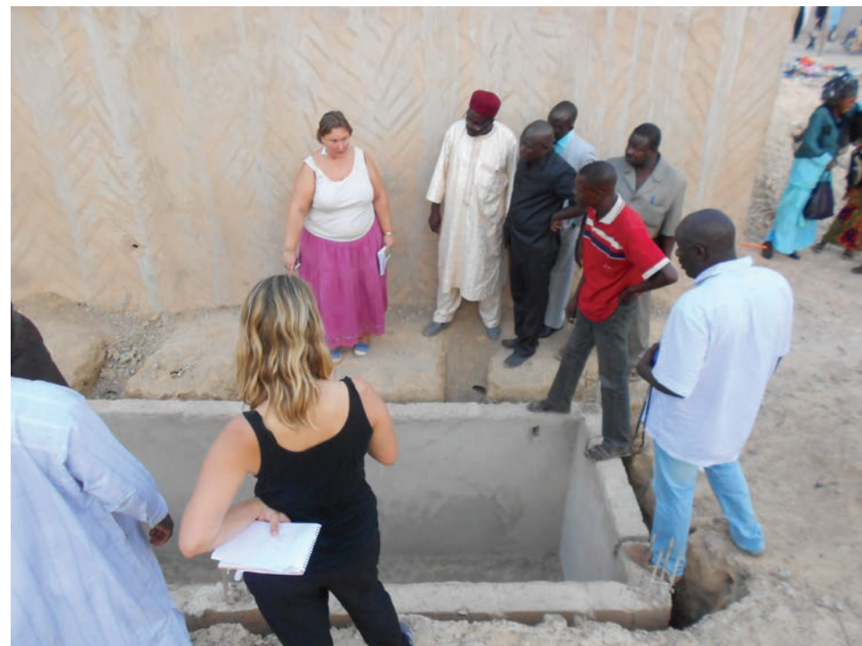
Visite de chantier en présence des experts du Val de Marne
