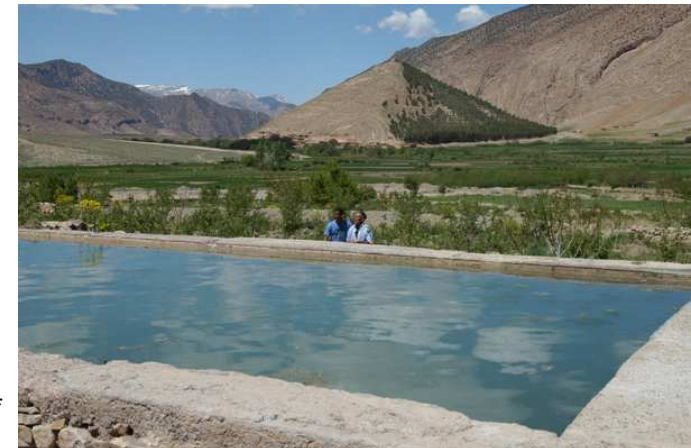
© IRD / Thierry Ruf Un bassin de rétention des eaux pluviales à ciel ouvert dans le Haut-Atlas.
