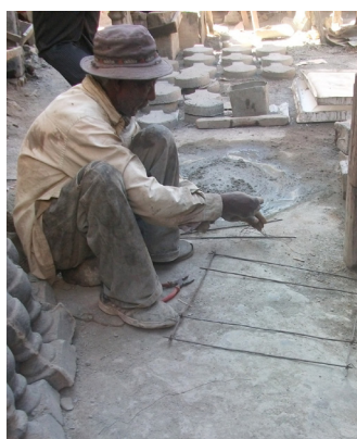
Maçon fabriquant une dalle SanPlat à Antananarivo
