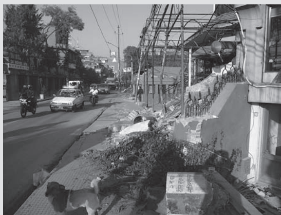
Gráfico R6.4.1 Edificios demolidos para garantizar el derecho de paso
