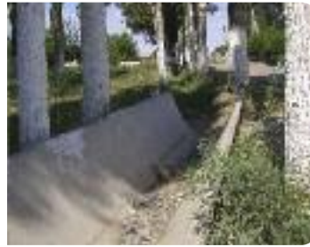
Canaleta de agua seca. © Kai Wegerich
