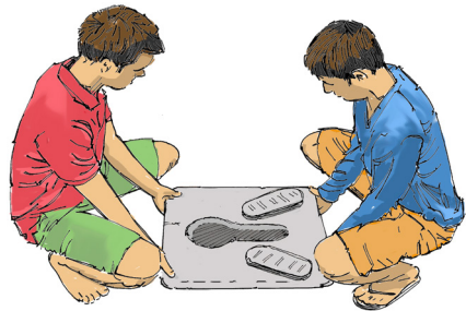
Figure 18. Lever une dalle Sanplat
