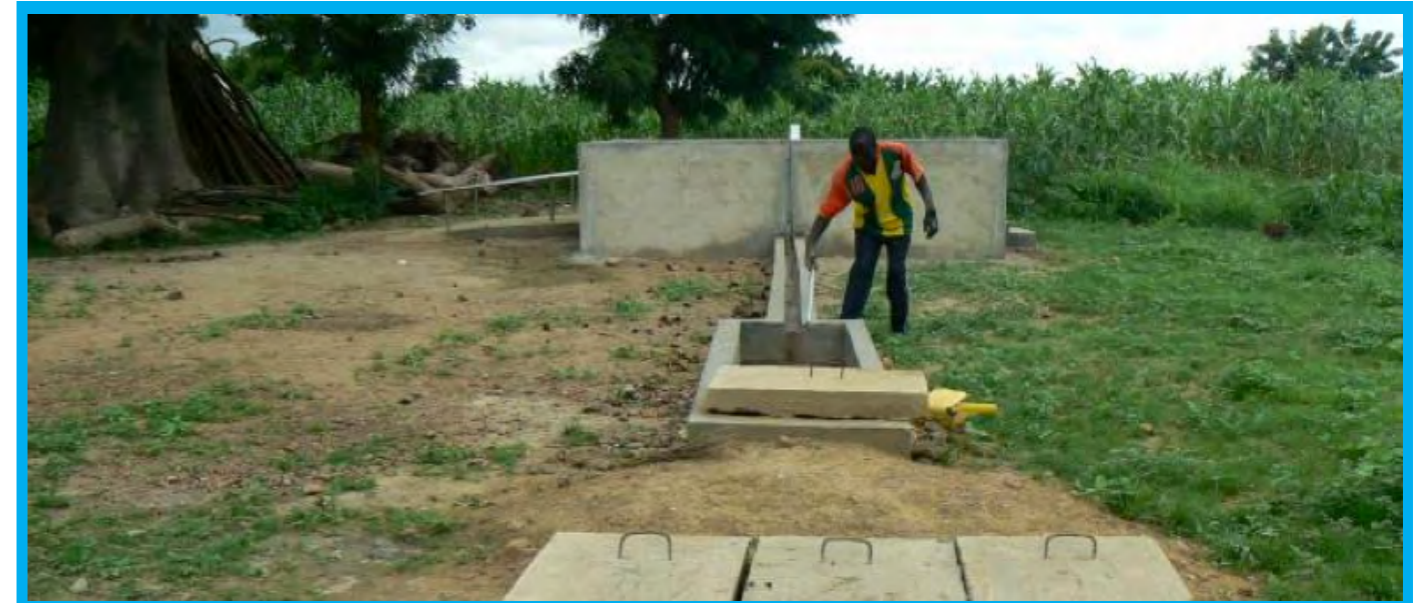
Burkina Faso: un forage équipé d'une pompe manuelle et d'abreuvoir pour bétail : une pratique courante en Afrique de l'Ouest.
