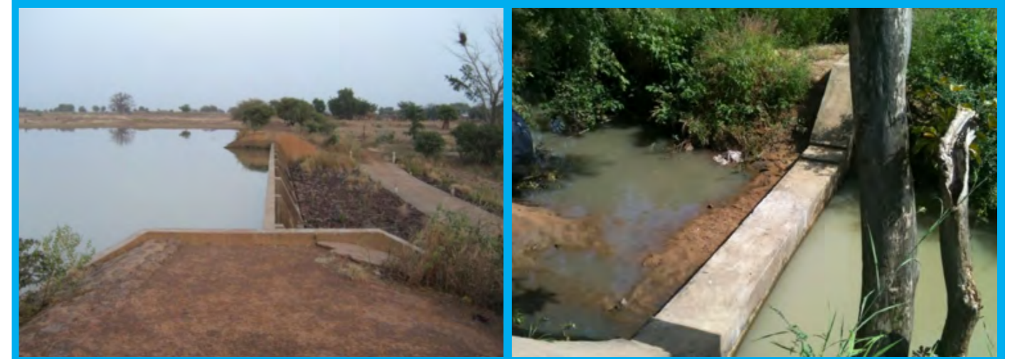
Burkina: un petit barrage et un barrage de sable pour réalimenter les eaux souterraines.
