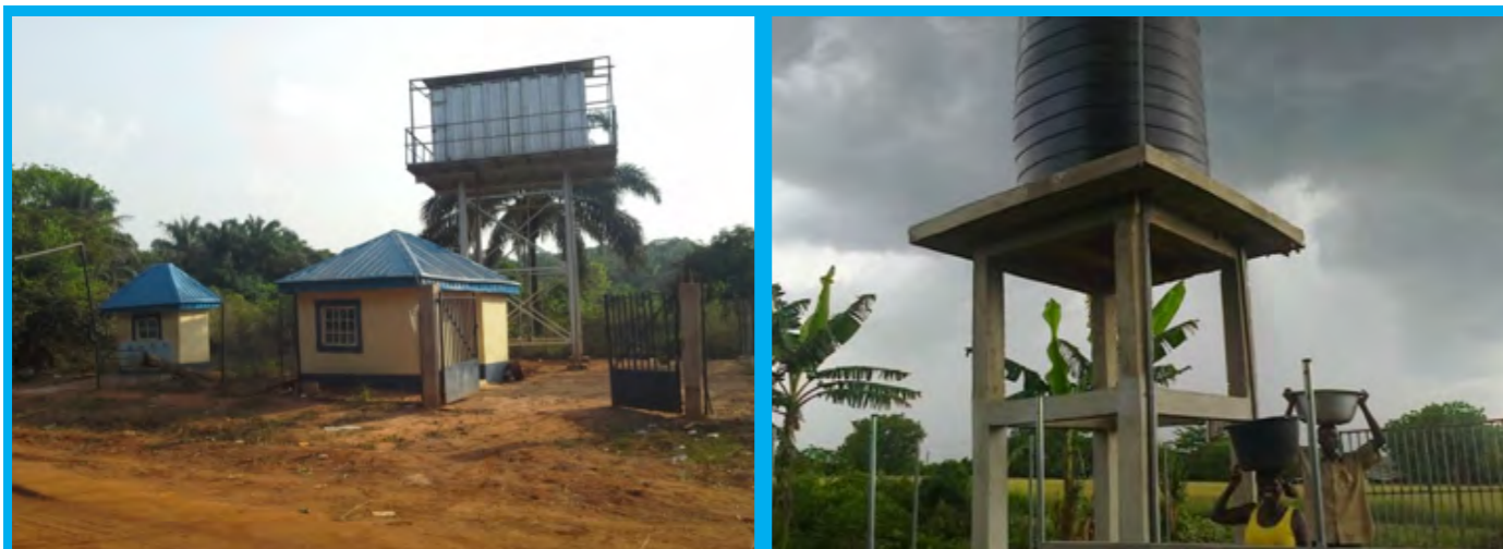
Nigeria (à gauche): vue du système d'approvisionnement en eau par énergie solaire de Umuofiagu, dans l'Etat d'Enugu constitué d'un château, d'un poste de contrôle à distance et d'une borne fontaine (avec des tuyaux d'eau élevés pour le réservoir qui collecte l'eau pour la construction et les autres besoins)
