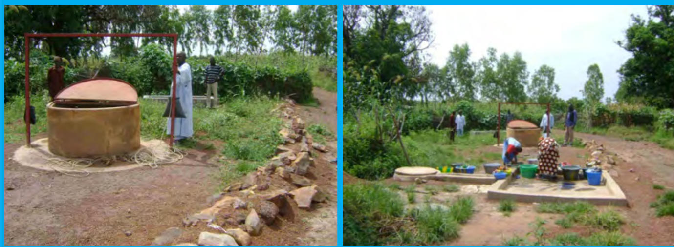
Mali: Puits à large diamètre réhabilité à Bablebougou avec des aires de lavage pour les femmes et des abreuvoirs pour bétail. Ce puits a permis de réduire la pression sur le forage du village pour une meilleure durabilité.
