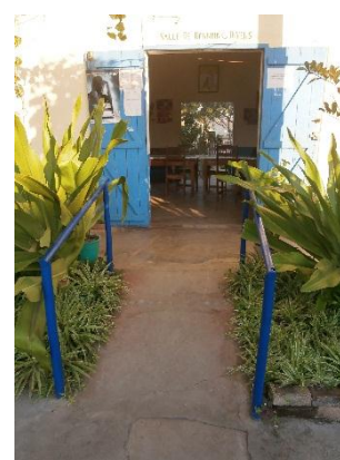
Figure 10 : Rampe d'accès au bureau de la DRPPSPF Morondava
