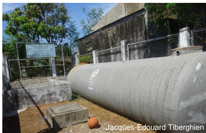
Ecotanque para comunidades ribereñas, San Fernando.
