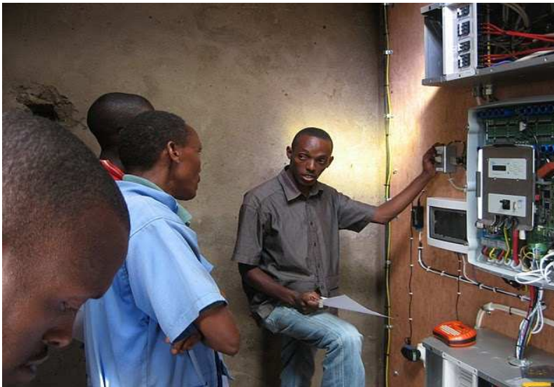
Le personnel contrôle le système d'énergie dans un centre de santé au Burundi. (Photo: Walt Ratterman, SunEPI)
