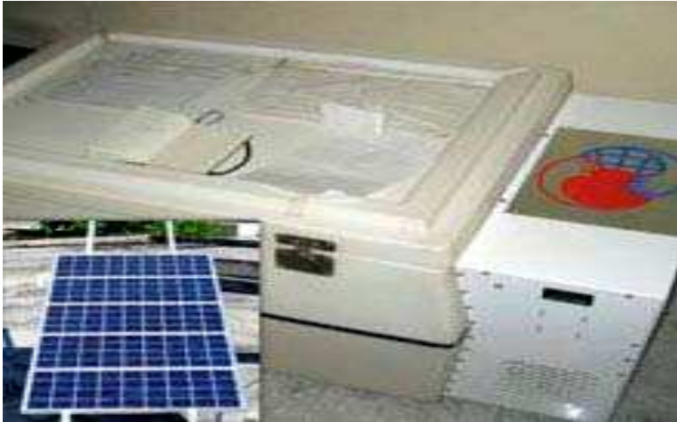
Ce réfrigérateur pour vaccins installé par l'Organisation mondiale de la santé et alimenté par un système solaire à Port Salut, en Haïti, fonctionne bien depuis deux ans grâce à un entretien et une gestion de l'énergie corrects. (Photo: Jeff Haeni, USAID)
