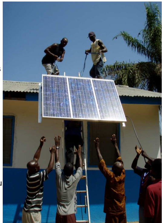
Installation de panneaux solaires sur un centre de santé au Libéria. (Photo: Gaurav Manchanda, Clinton Foundation)
