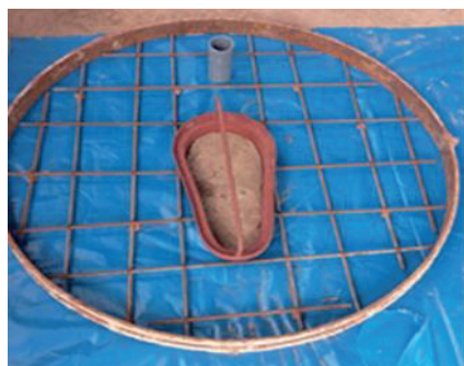
Ferraillage dalle avec SATO
