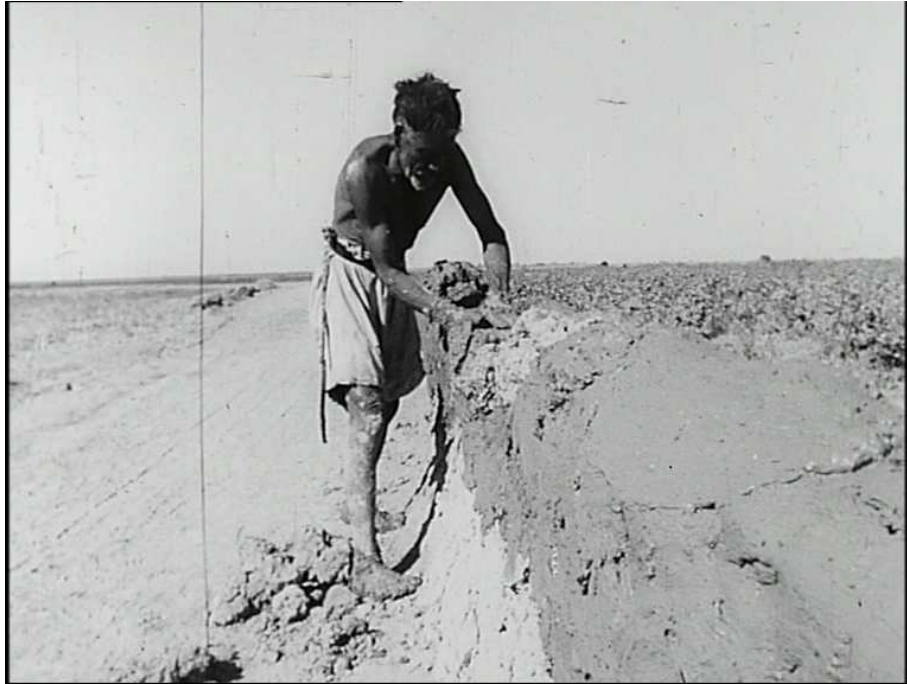
Figure 13 : Un vieil homme rachitique qui construit seul un mur 225
