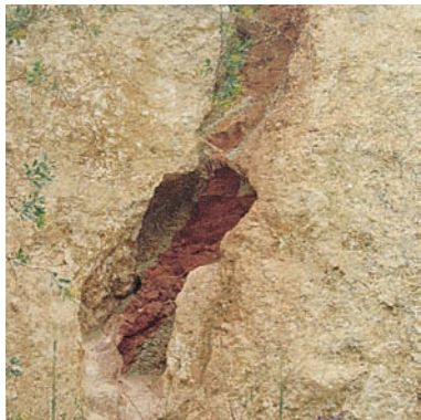
Photo 3: Cavité dans le C4, remplie par de l'argile.
