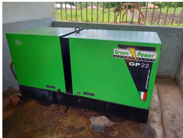
Figures 1 et 2. Mini-réseau du projet ERSEN, avec ses 24 panneaux solaires, son local de stockage de batteries et d'onduleurs (photo de gauche) et son générateur diesel (photo de droite)
