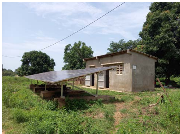
Figures 1 et 2. Mini-réseau du projet ERSEN, avec ses 24 panneaux solaires, son local de stockage de batteries et d'onduleurs (photo de gauche) et son générateur diesel (photo de droite)
