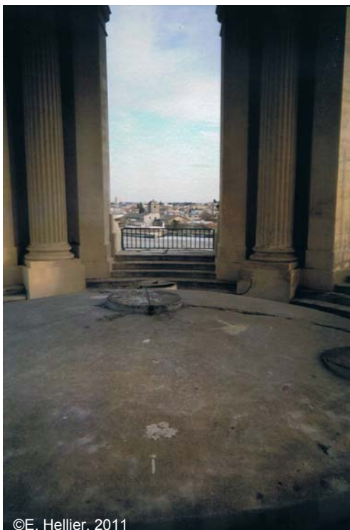
3 - Réservoir du Peyrou à Montpellier
