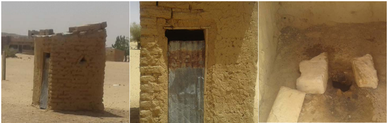
Latrines auto construites dans les communes
