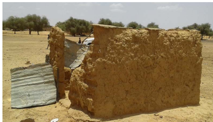
Latrines auto construites dans les communes
