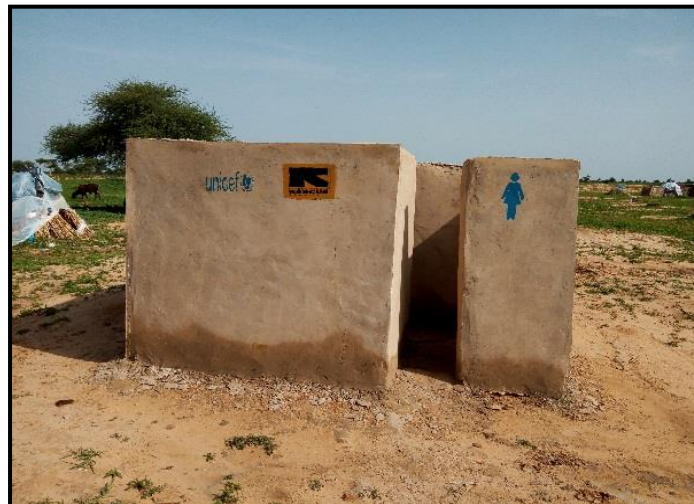
Photo : Bloc latrine semi-durable en banco, IRC, juin 2016
