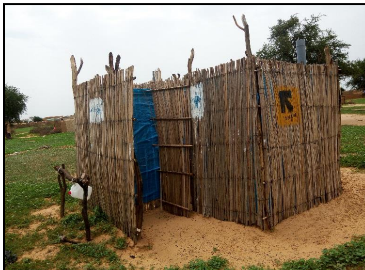
Photo : exemple de bloc public de latrine d'urgence, IRC, juillet 2016
