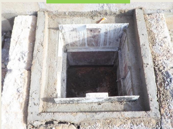
Regard à l'entrée du chenal d'évacuation
