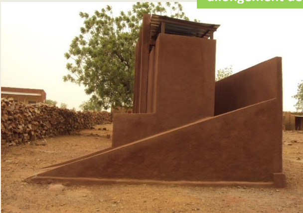
Latrines surélevées : redimensionnement de la fosse et allongement de la rampe d'accès
