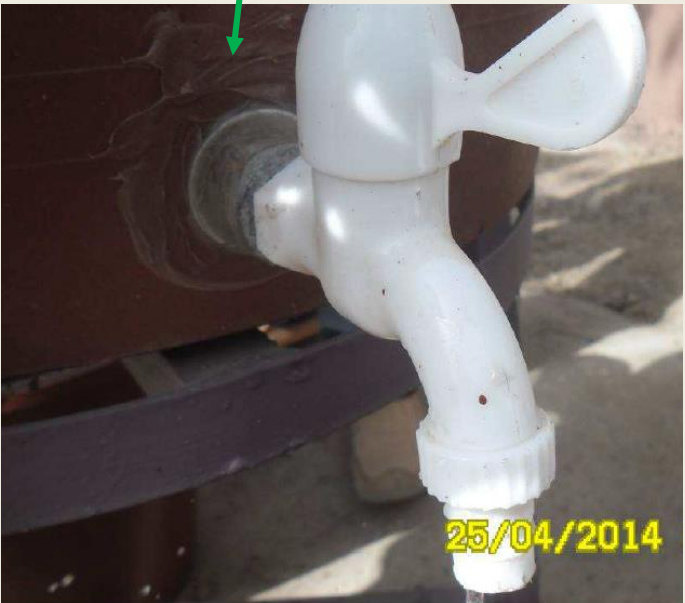
À l'intérieur du réservoir, l'embout métallique est serré par un écrou plastique ou métallique
