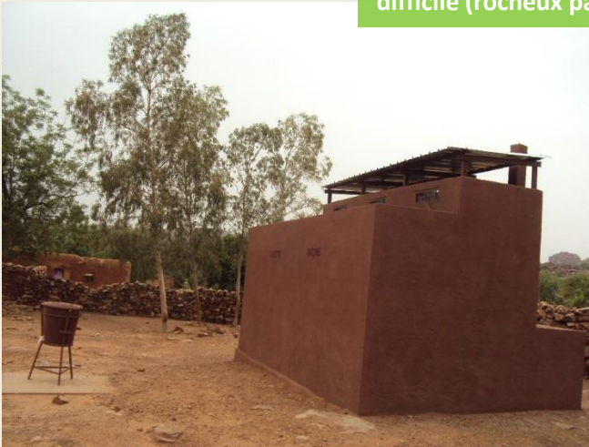
Bloc de latrines surélevé en terrain difficile (rocheux par exemple)
