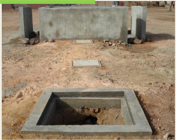
Chenal d'évacuation équipé de 2 regards et conduisant à un puisard de 2m de profondeur rempli de moellons
