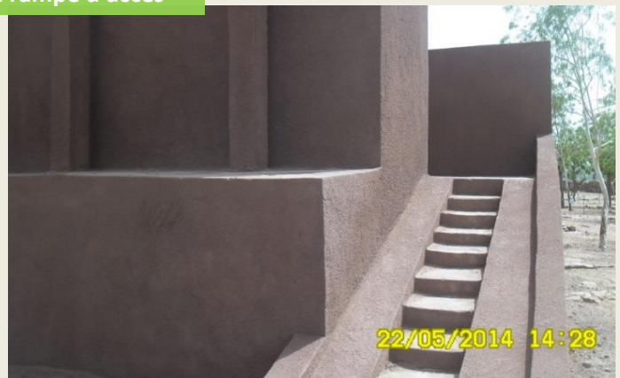
Latrines surélevées : redimensionnement de la fosse et allongement de la rampe d'accès
