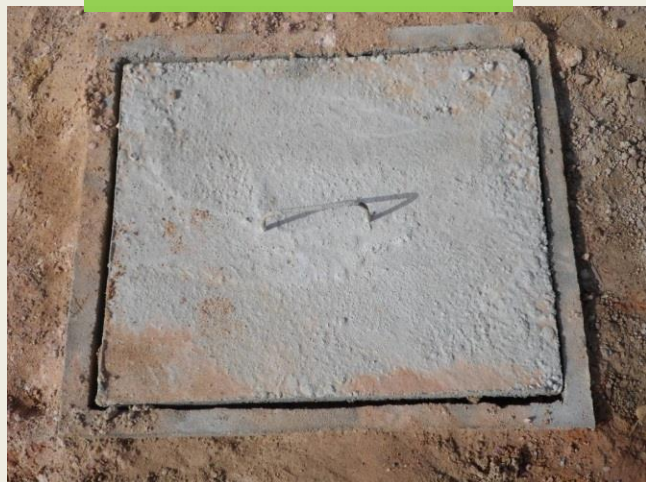
Dalle de couverture du regard bien encastrée et équipée d'une poignée couchée
