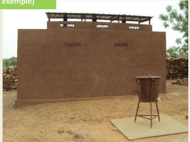
Bloc de latrines surélevé en terrain difficile (rocheux par exemple)
