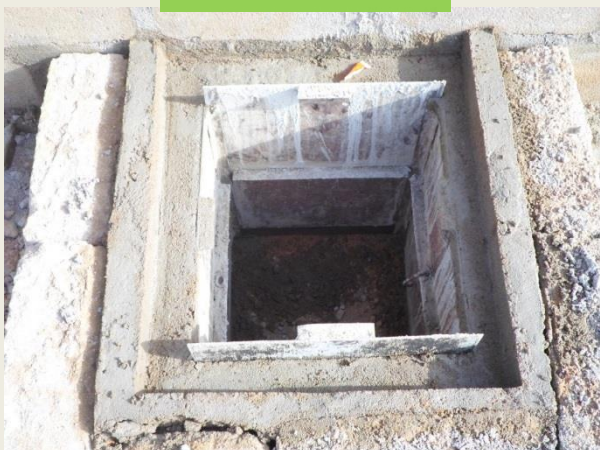
Regard à l'entrée du chenal d'évacuation
