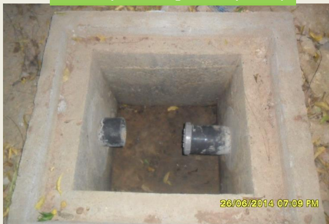
Regard intermédiaire (à mi-chemin entre le premier regard et le puisard)
