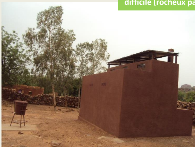
Latrines surélevées : redimensionnement de la fosse et allongement de la rampe d'accès
