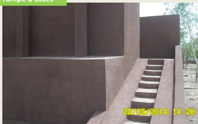
Latrines surélevées : redimensionnement de la fosse et allongement de la rampe d'accès
