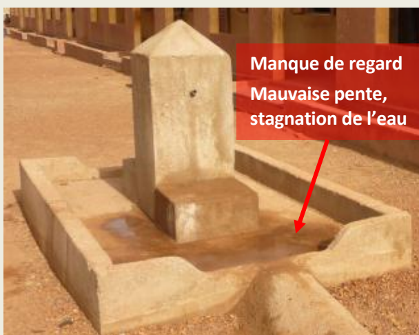
Aire assainie en gravier à la place du béton
