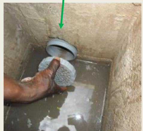
Intérieur du regard de décantation : bouchon anti-gravier en PVC percé bloquant l'entrée de matériaux solides dans le chenal
