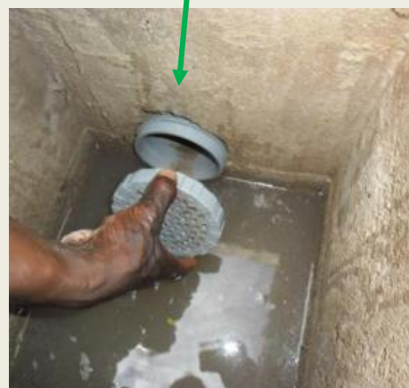
Intérieur du regard de décantation : bouchon anti-gravier en PVC percé bloquant l'entrée de matériaux solides dans le chenal
