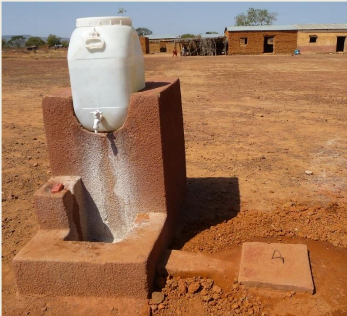
Réservoir plastique amovible posé sur un support en ferrociment. Robinet. Porte-savon. Puisard.
