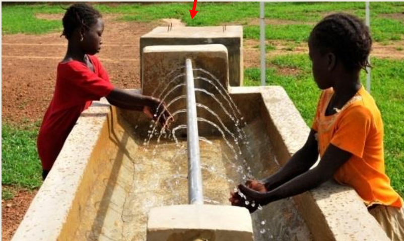
Réservoir d'eau trop petit
