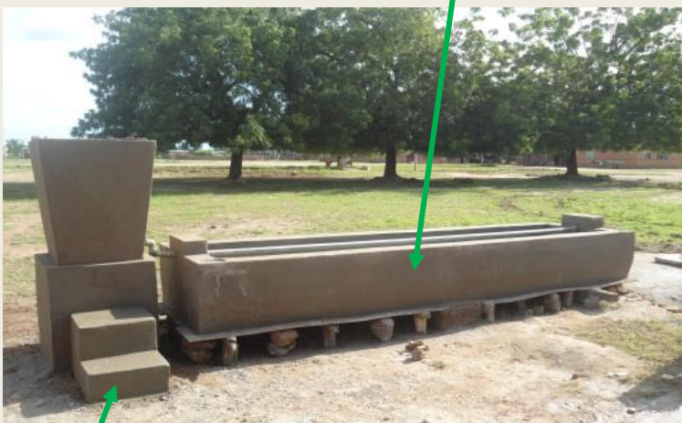
Marches facilitant l'accès au réservoir
