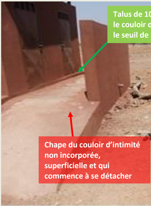
Couloir d'intimité en pente (5-7%) vers l'extérieur pour éviter la stagnation d'eau
