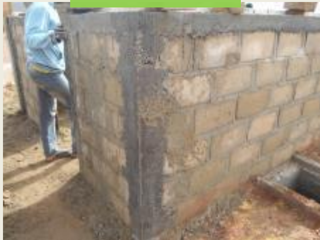
Murets renforcés par des poteaux et un béton de couronnement
