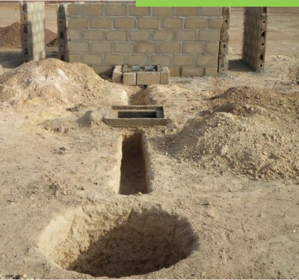
Chenal d'évacuation équipé de 2 regards et conduisant à un puisard de 2m de profondeur rempli de moellons
