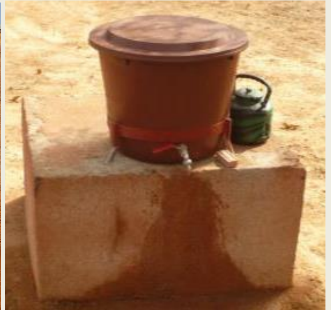
Réservoir PVC « samarakolon » amovible, positionné dans un cercle métallique fixé sur un support en ferrociment. Robinet. Porte-savon. Aire anti-bourbier ou puisard.
