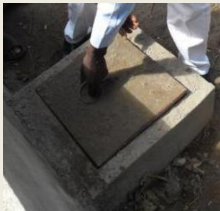
Dalle de couverture du regard encastrée et fermeture équipée d'une poignée couchée
