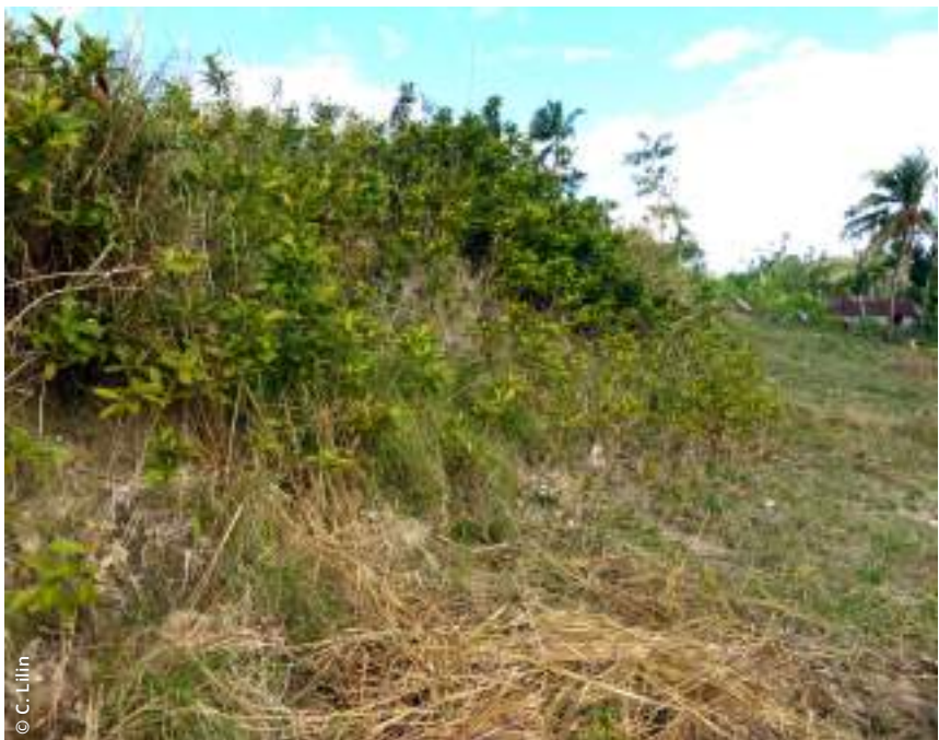
Talus partiellement renforcé.
