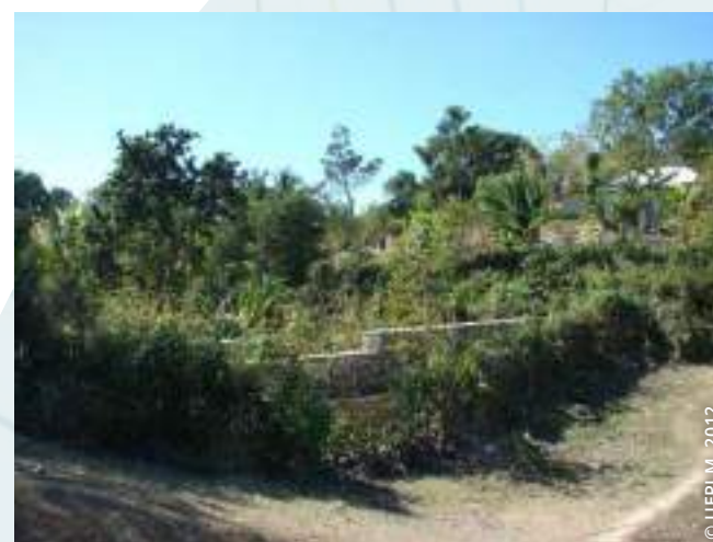
Exemple de complémentarité entre un aménagement biologique et un aménagement en dur : la haie de candélabre limite l'affouillement du radier du seuil. Ravine Chatelain à Gros-Morne.
