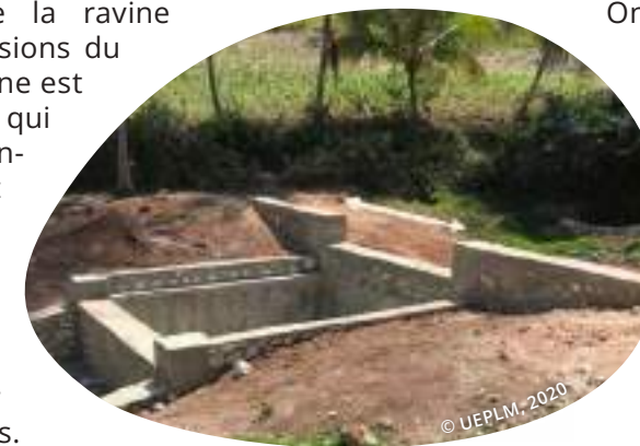
Seuil de fond de vallon dans la ravine Kady à Marcabée. La largeur du déversoir est représentée par la flèche blanche sur la photo.
