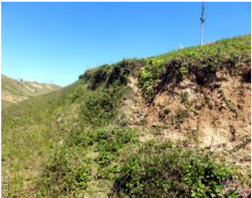
Talus créé par érosion aratoire.
