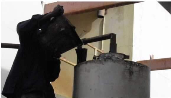
Figure 4.10: Remplissage du réservoir d'huile
