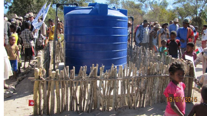
Réservoir plastique de 5 m3 à Ambatry
