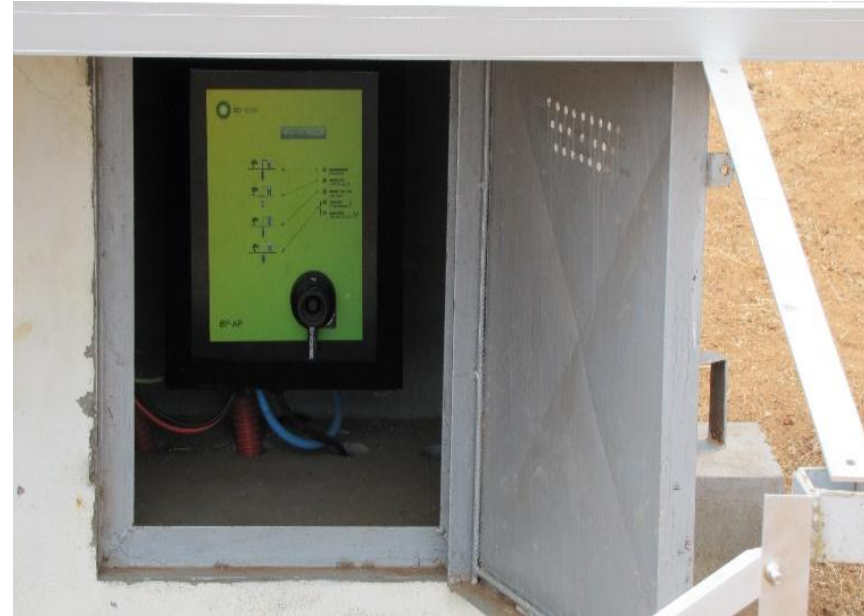
BP SOLAR 125W pompe standard et son onduleur avec pompe standard de 1,1 à 5,5 kW
