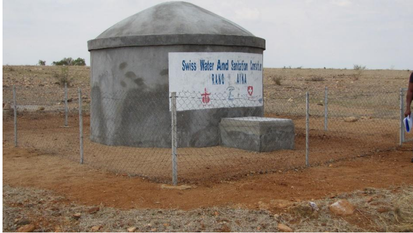
Réservoir en ferro ciment de 12 m3 à Vohipotsy
