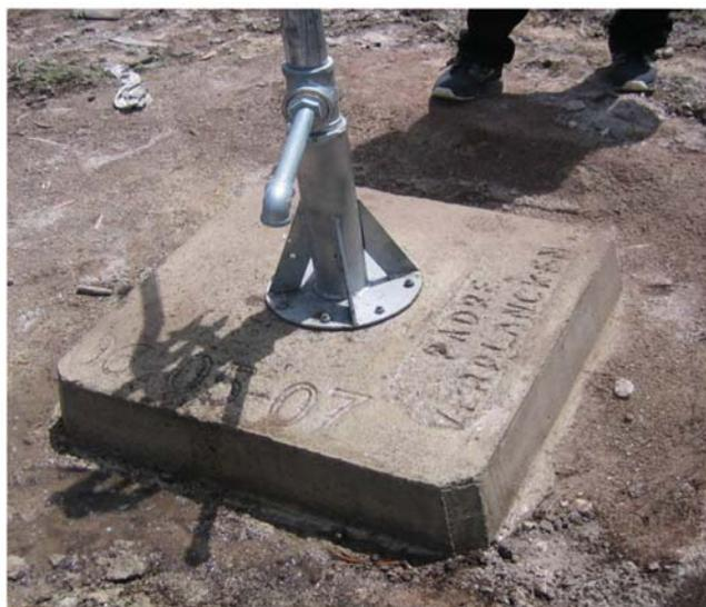
Un numéro d'identification de forage permanent ou la nomenclature doivent se trouver sur chaque forage et dans la documentation connexe
