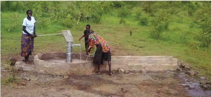
Amménagement de forage avec une dalle correcte et drainage
