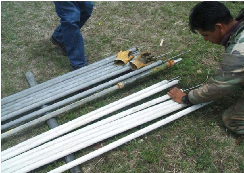
Protégez la pompe et le tuyau contre tout contact direct avec le sol lors de l'installation et de la maintenance.
