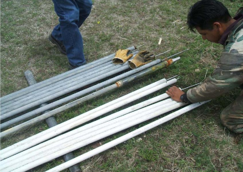
Proteger la bomba y el tubo de caída del contacto directo con el suelo durante **INSTALACIÓN** y mantenimiento
