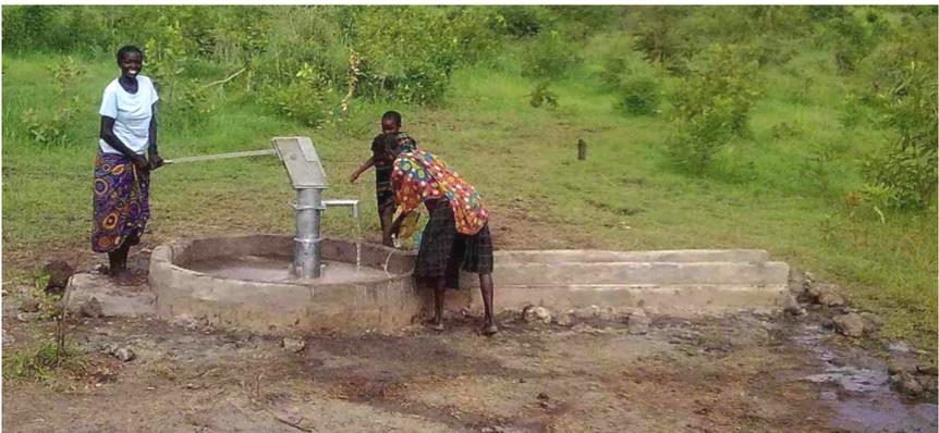
Cabezal de pozo con buena plataforma y drenaje
