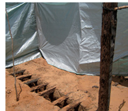
Lors des foires de biens de premières nécessités organisées par nos équipes, celles-ci doivent construire des tranchées de défécation qui sont ensuite recouvertes de terre afin de remettre le site à l'état original une fois les foires terminées.
