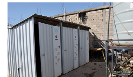
Au Liban, les latrines sont construites en zinc, matériau résistant mais considéré comme temporaire et posées sur des fosses septiques (étanches) ou des fosses d'infiltration (non-étanches).
