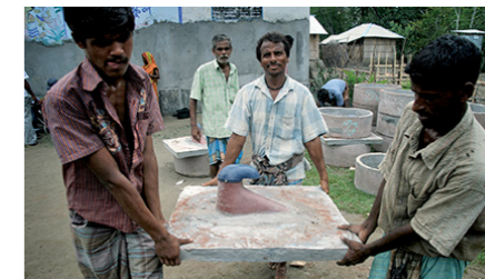
Grâce à un réservoir à biogaz, ces latrines permettent de générer du méthane qui produit une énergie propre, ainsi que des résidus solides qui peuvent être utilisés comme engrais naturels.
