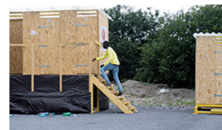
Construction de latrines surélevées sur cuves plastiques hermétiques
