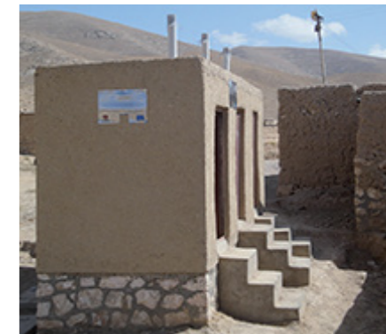
Grâce à un système de dérivation, ces latrines permettent de séparer les résidus liquides et solides selon les normes définies par le gouvernement.
