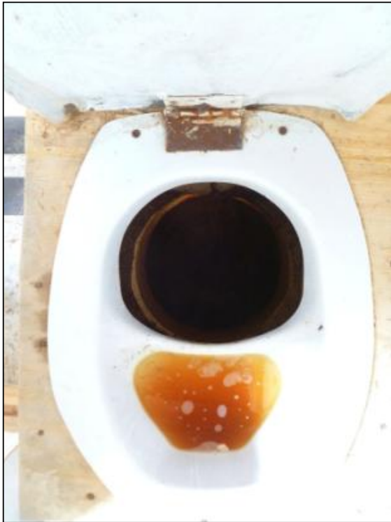
MOVE FOTO T1: Tiyo pipi a bouche nan yon twalèt UD SOIL.
