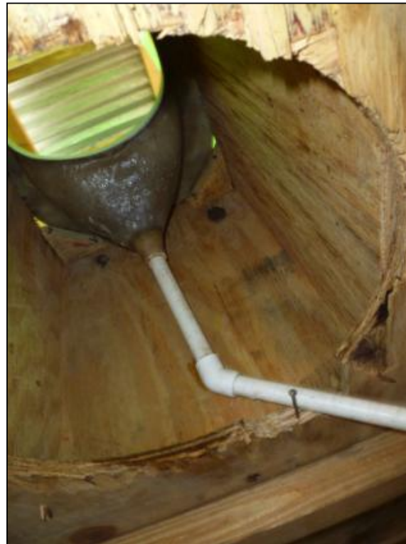
FOTO T13b: Tèt twalèt UD SOIL la, lè ou gade l nan twou pou pou a.
