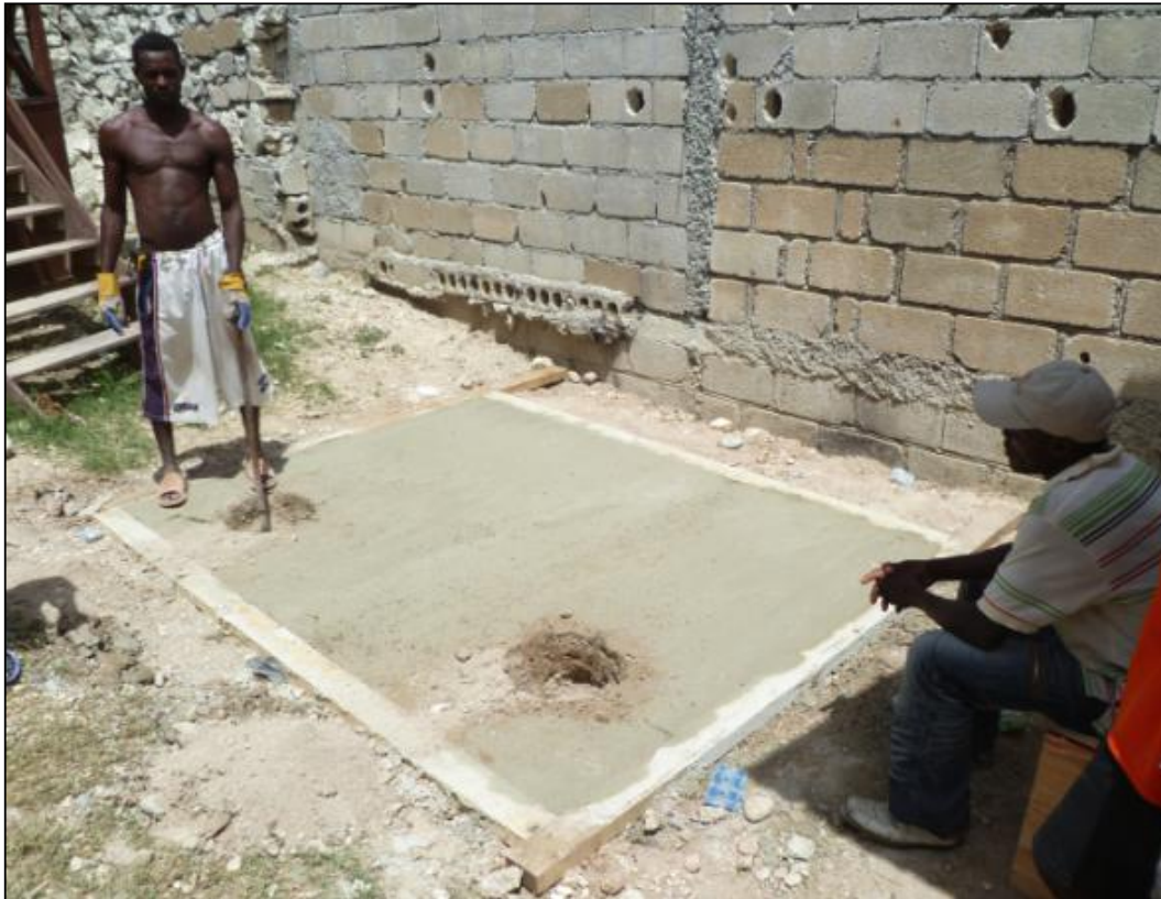
FOTO T3: Y ap fouye twou pwi pèdi a epre ke yon fin fè baz dal beton an
