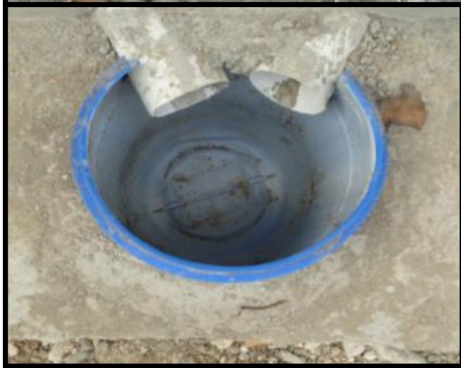
Foto K108: Dren pou ji yo, soti nan 2 konpatiman strikti konpòs la pou rive nan yon sèl droum 15 galon.
