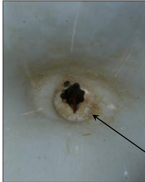
MOVE FOTO T4b: Premye tèt twalèt UD SOIL yo, nou blije laji twou drenaj yo pou debouche tiyo pipi a.
