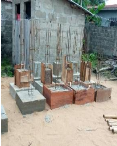
Socles de balises préfabriqués
