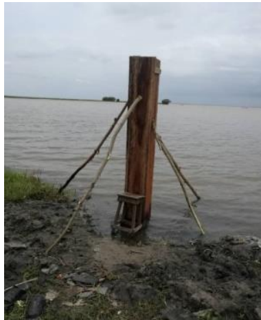
Poteau de balise coulé
