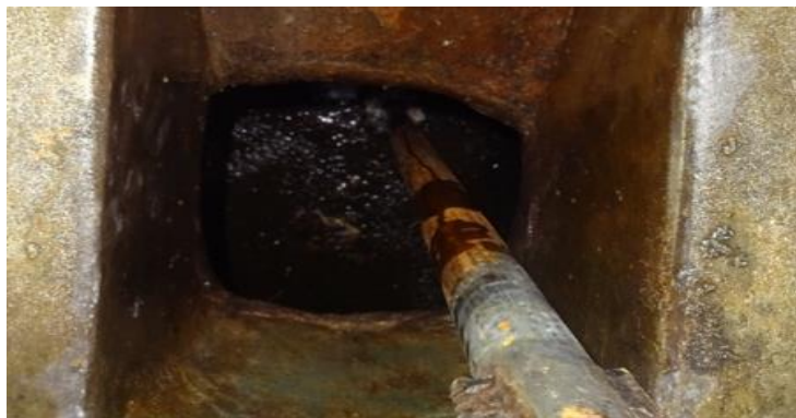
Diagnostic de fosse à l'aide d'une barre à mine graduée Source : enquête, terrain 2020
