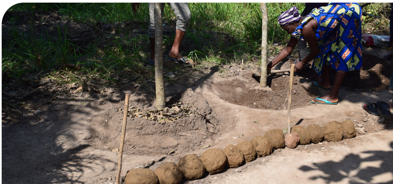
Formation sur la réalisation de dispositifs de conservation des eaux et des sols (SNV Bénin)
