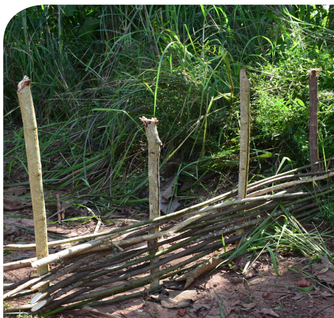
Réalisation de fascines pour freiner l’érosion hydrique (CIDR-Pamiga)
