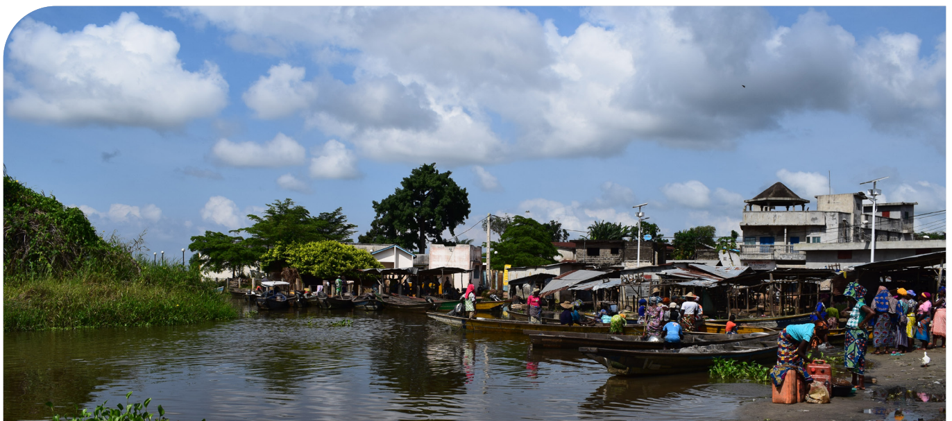
Marché de la commune de Porto-Novo à protéger contre les inondations (SNV Bénin)
