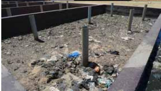
Présence de déchets solides sur lits de séchage => dégrillage à réaliser
