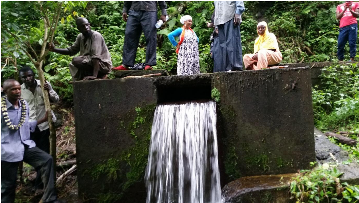
Le trop-plein de la chambre de mise en charge du captage
