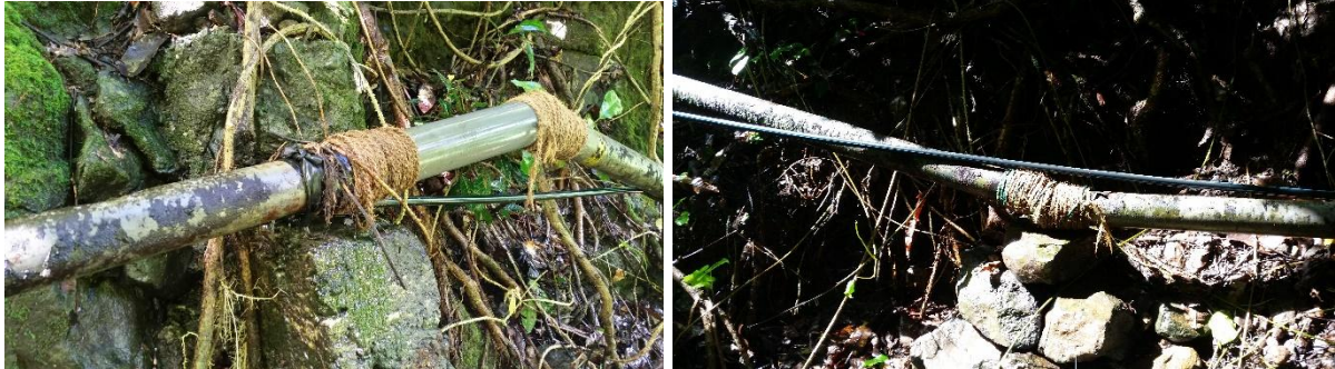
L'état de la conduite d'adduction
