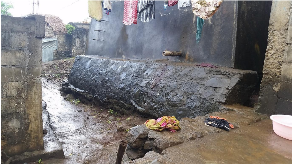
Le réservoir est à proximité immédiat des habitations
