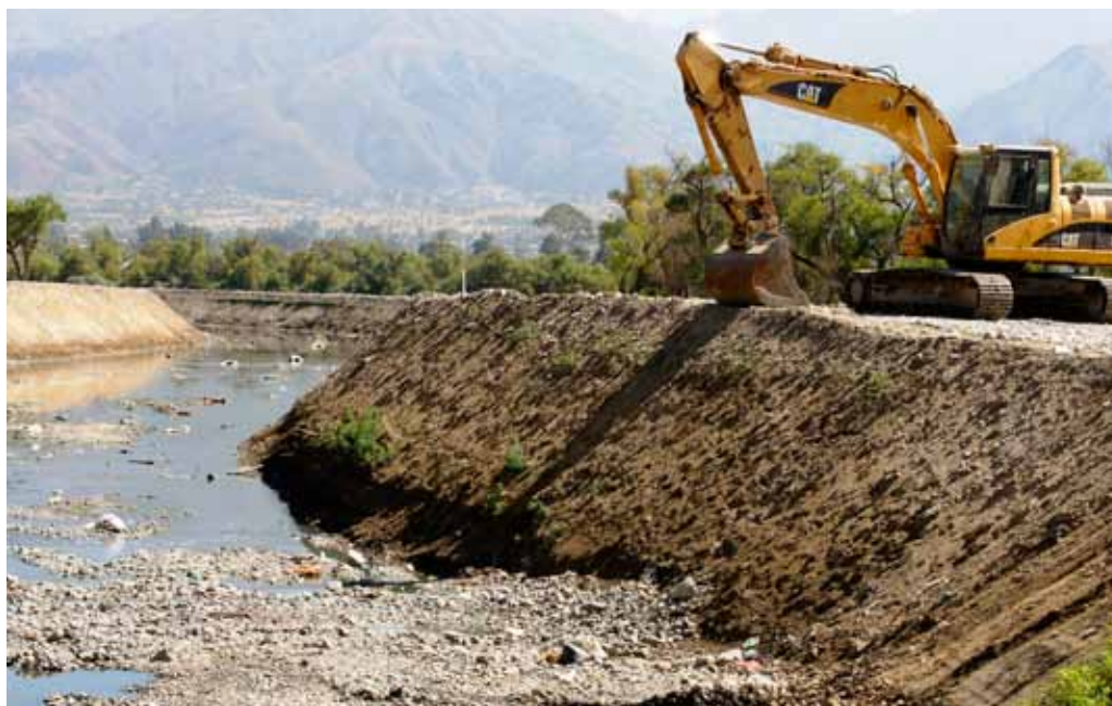
Foto 15. Acondicionamiento hidráulico en el sector de Pico de Loro-Vinto- Fase I.
