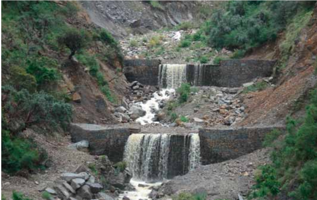
Foto 14. Gavión construido en la cuenca Thola Pujru
