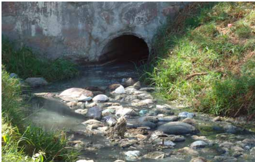
Foto 7. Descarga de aguas residuales en el río Rocha en el Cercado
