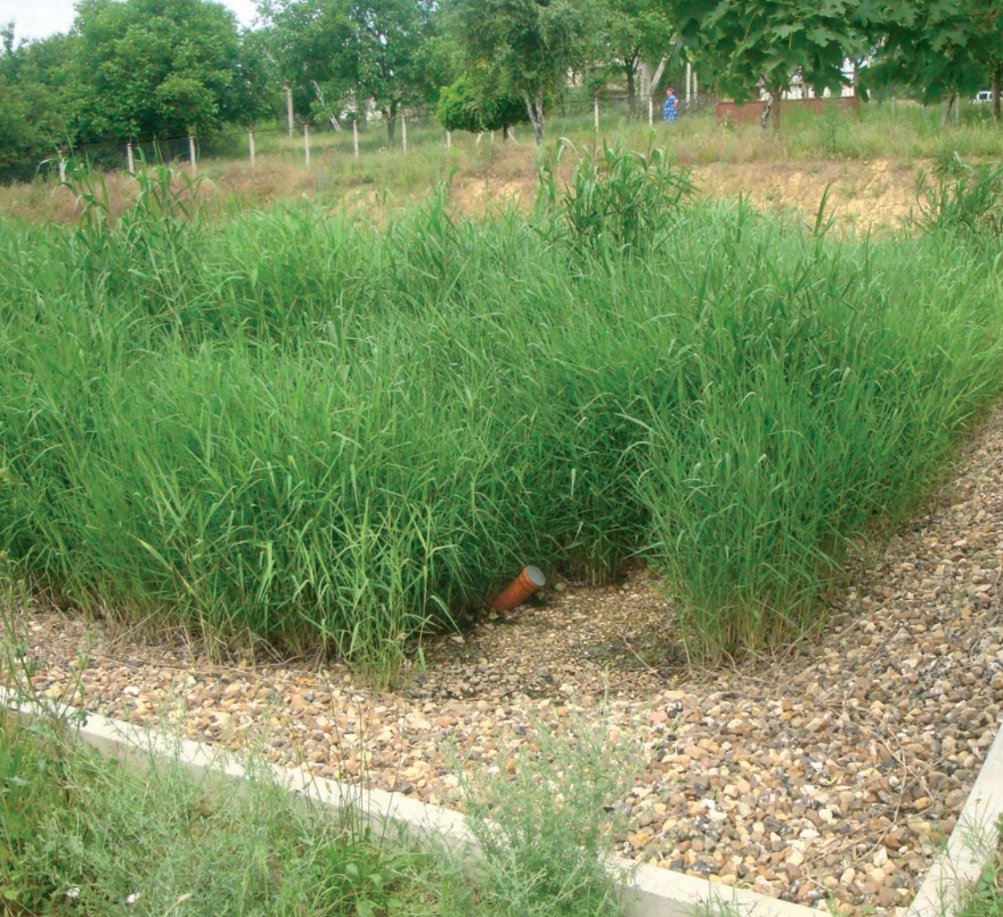
Image 9 : Filtres plantés de roseaux à Sărata Galbenă (photo : ApaSan)
