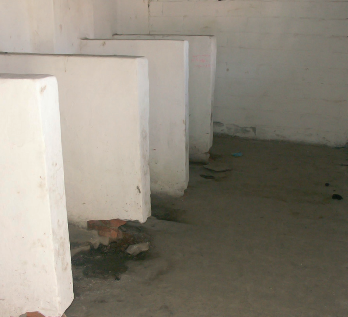
Image 5 : Installations sanitaires typiques d'un lycée (photo : SEE)
