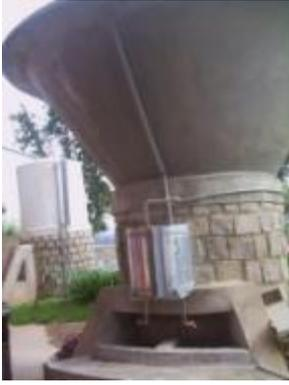
**Réservoir surélevé à moindre coût en en ferrociment .3 fois moins cher que les réservoirs en plastique et 10fois moins cher que les réservoirs en béton armé. Lavoir maîtrisable volumétriquement utilisant à la fois des eaux de pluies ou de l'eau du réseau.**
