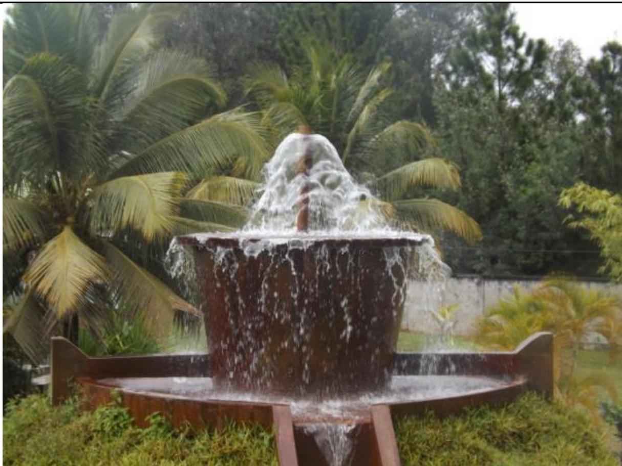
Conception et réalisation par Sandandrano de l'aérateur en ferrociment d'un système d'Alimentation en eau potable par pompage
