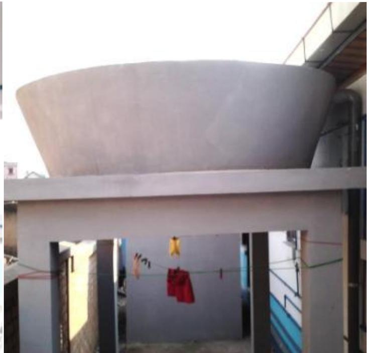
**Dopage d'un lavoir maîtrisable volumétriquement et d'un réservoir en ferrociment pour récupération des eaux de pluie d'un bloc sanitaire existant à Antananarivo ville (alimentation mixte : eaux de pluie, eau du réseau, eau recyclée) .**
