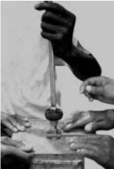
3) Si la tige supérieure est raccordée, abaisser l'ensemble des tiges jusqu'à ce qu'elle repose sur le clapet de pied. Pousser doucement le clapet de pied dans sa position finale (une tige de pompe additionnelle est requise).
