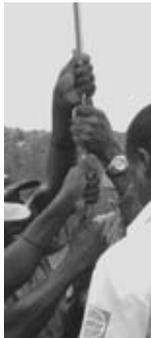
2) Installer le piston et toutes les tiges de pompe à l'aide de l'outil d'arrêt.
