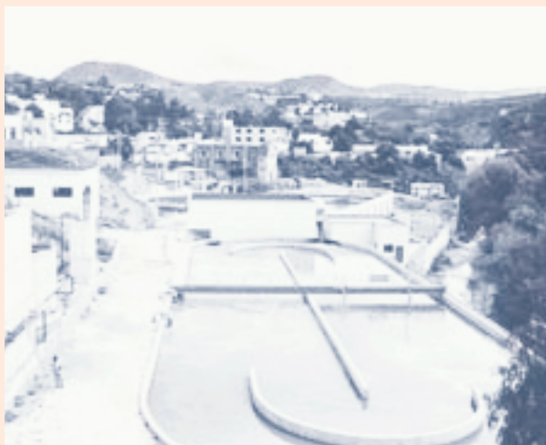
Une vue aérienne de l'usine de traitement des eaux à Guanajuato mexique
