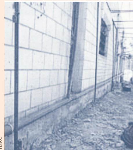
Collecte des eaux grises au moyen de tuyaux le long des murs extérieurs des maisons
