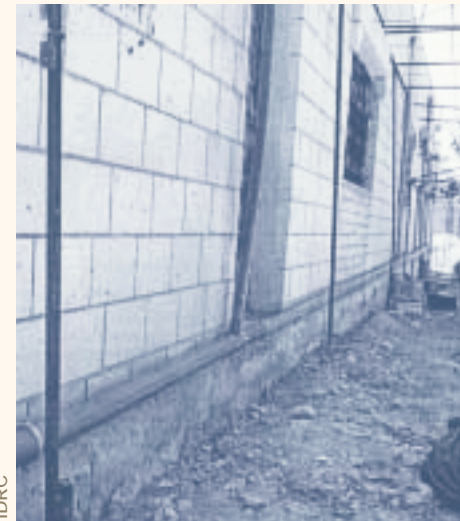
Aguas grises colectadas en tuberías a lo largo de las paredes exteriores de las viviendas.
