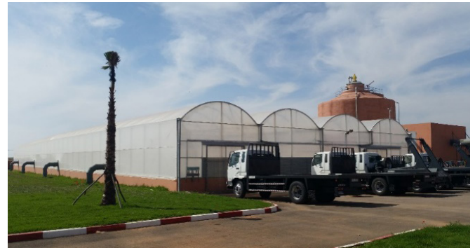
Figure 4: Serres de séchage des boues à Youssoufia (a) et Ben Guérir (b), Maroc (Thermo-System, 2017)
