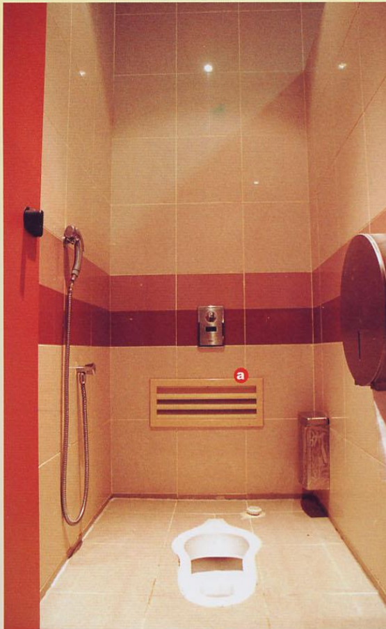
a. Intake Grilles
