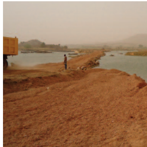
Site Barrage Kandadji
